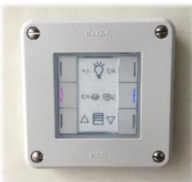
Eine Licht- und Beschattungsteuerung mit KNX System in der Wohnung und auf der Terrasse mit elektrischem Sonnensegel sorgen ganzjährig für ein auf den Nutzer abgestimmtes Ambiente zum Wohlfühlen. Über einen verschlüsselten Zugriff sind die Fernwartung und Steuerung der Visualisierung von überall aus möglich. Es wurde eine intelligente Videogegensprechanlage mit Fernzugriff implementiert, genauso wie eine benutzerorientierte Sicherheitsüberwachung der externen Räume im Untergeschoss.
